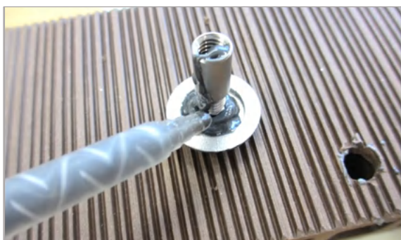
⑥点字鋏裏面に接着剤を塗布する
