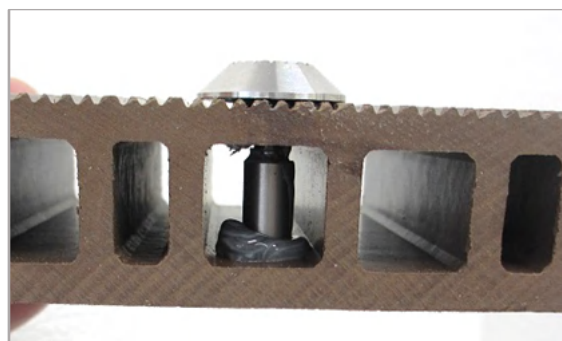
⑦点字鋏をウッドデッキに埋込み固定する
