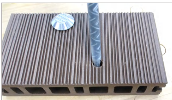
③表面より接着剤を注入する
