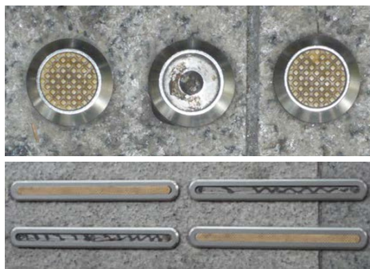
樹脂部の脱落
