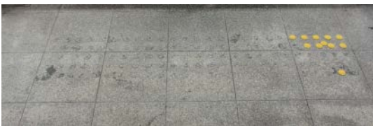
点字鉄がほぼ脱落してる状況
