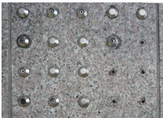
床からの脱落・鋏の頭のキャップの外れ
