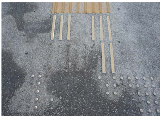
警告・誘導鋏の脱落
