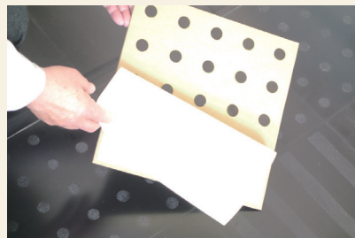
裏面のリケイ紙を剥がし、墨に合わせて貼り付ける。
